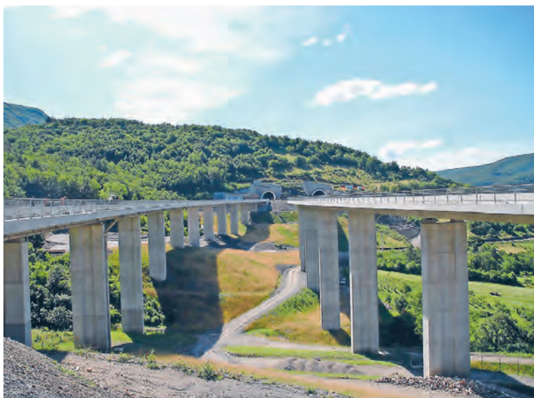
Gradnja najzahtevnejšega dela vipavske hitre ceste prek Rebrnic je trajala vse od leta 2002 do leta 2009.
